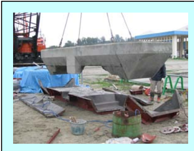
④型枠脱型
