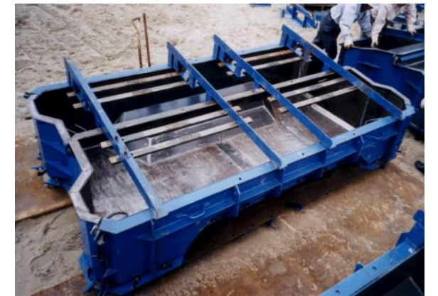
型枠写真 (SW-12形)
