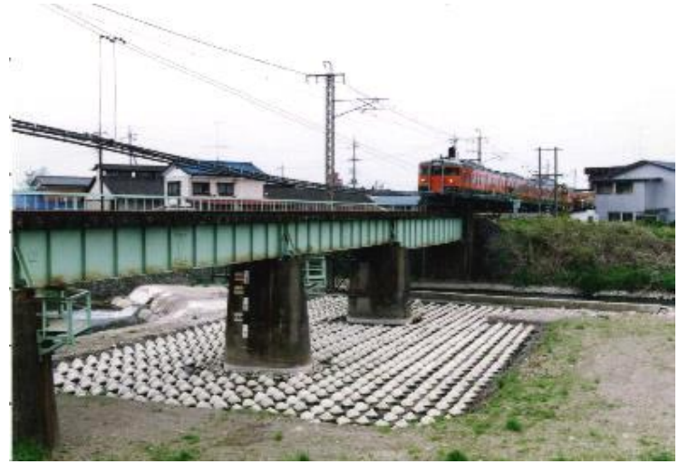
群馬県伊勢崎市 粕川 (国定・伊勢崎間粕川橋梁) コーケンブロック 0.5 × 3 (1.5t級) コーケンブロック 0.5 × 4 (2.0t級) コーケンブロック 0.5 × 5 (2.5t級)
