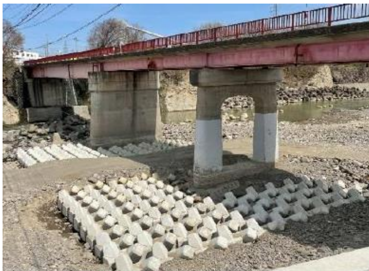
長野県東御市 千曲川 (境橋) コーケンブロック 2.0t型 × 4単位 (8.0t級)
