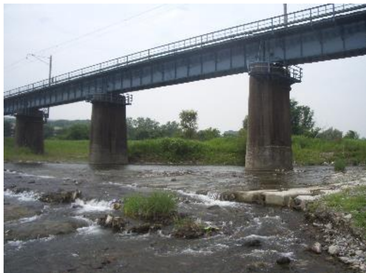
東京都八王子市 多摩川 (八高線) コーケンブロック 変形1.0t型 × 3単位 (2.5t級) コーケンブロック 変形1.0t型 × 4単位 (3.0t級) コーケンブロック 変形1.0t型 × 5単位 (4.0t級)
