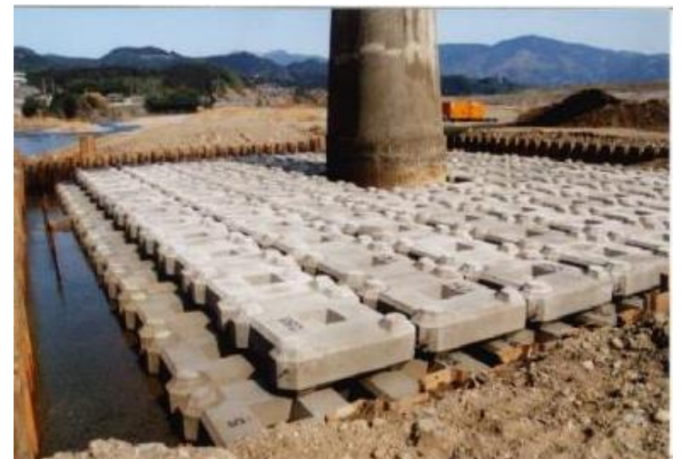
愛媛県大洲市 肱川（肱川橋） セッカブロック C形4t型 セッカブロック 半割4t型
