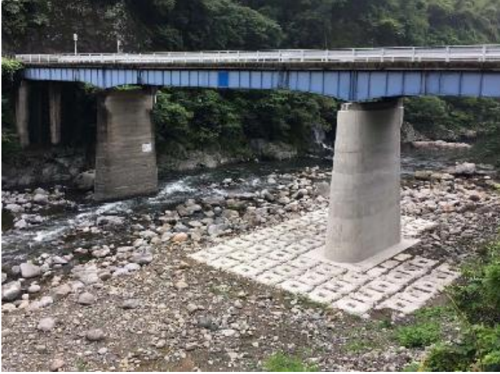
群馬県みどり市 渡良瀬川（新栄橋） セッカブロック C形3.0t型・半割3.0t型
