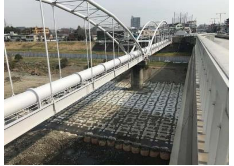
東京都調布市 多摩川（多摩川原水道橋） セッカブロック C形3.0t型・半割3.0t型
