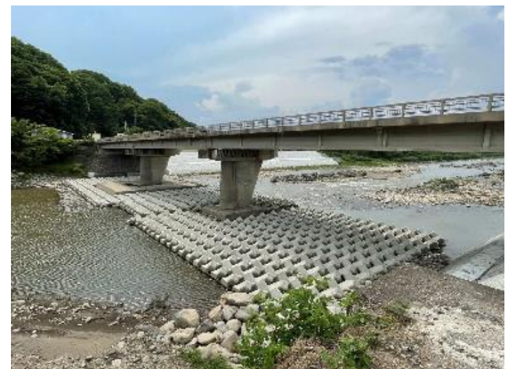
長野県東御市 千曲川 (田中橋) コーケンブロック 2.0t型 × 4単位 (8.0t級)
