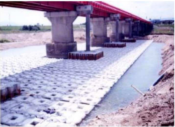
三重県鈴鹿市 鈴鹿川（庄野橋） セッカブロック C形2t型 セッカブロック 半割2t型
