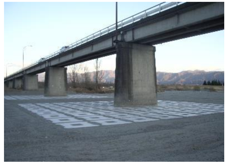
山梨県南アルプス市 釜無川（鏡中条橋） セッカブロック B形5t型
