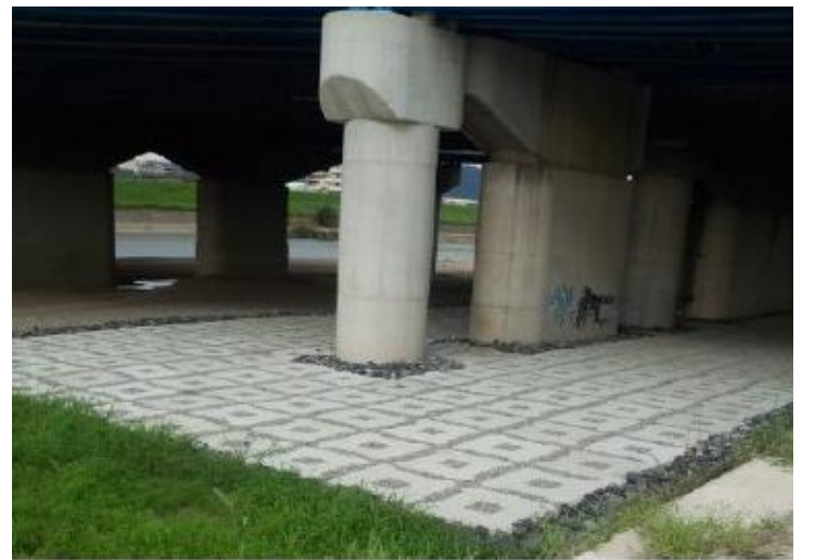
大阪府松原市 大和川（松原ジャンクション下部） セッカブロック B形2.0t型
