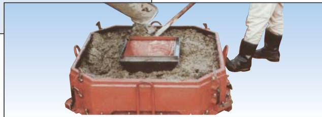
パイプレーターをかけながらコンクリートを打ち込み、荒均しをします。
