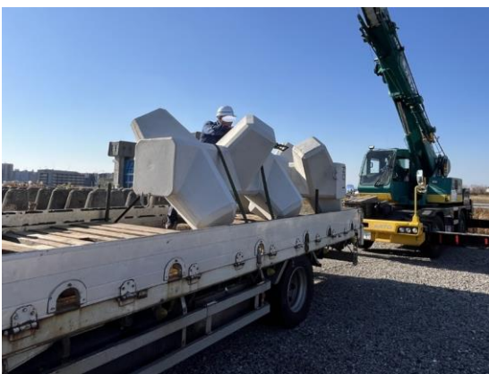
ブロック現場搬入
